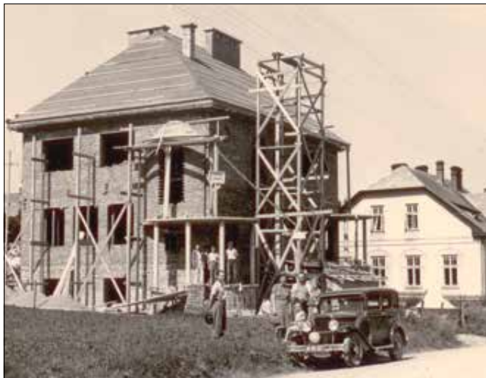
Stavba nové budovy české menšinové školy v Rýmařově, 9. 7. 1938
