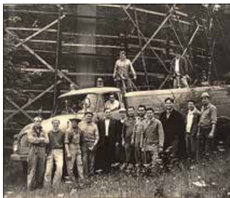
Oprava kaple V Lipkách
