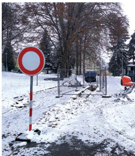
Začala rekonstrukce části ulice Julia Sedláka
