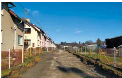
Opravy silnice v ulici U Rybníka budou pokračovat do 18. prosince
