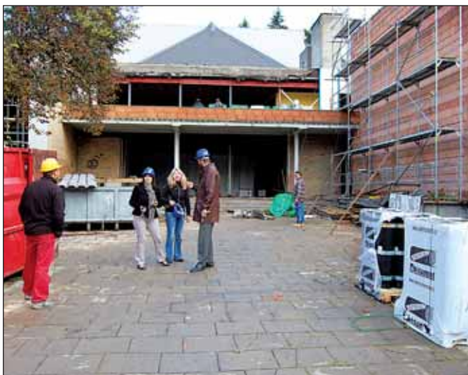
Rekonstrukce hrubé stavby SVC, 2011
