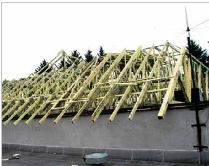
Oprava střechy SVC, léto 2001
