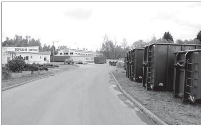
Odpadové centrum na ulici 8. května s velkoobjemovými kontejnery
