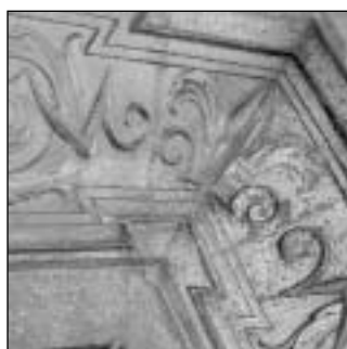
Rýmařov - Radniční č. 13 - vchod do domu mezi „Zlatnictvím“ a „Knihkupectvím“.
