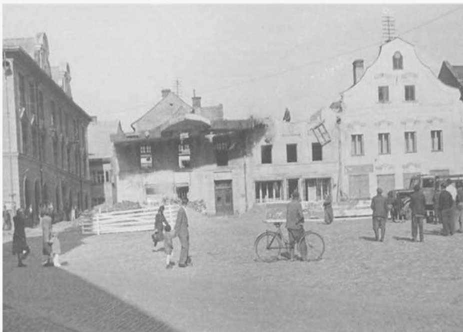
Demolice západní fronty domů nám. Míru
