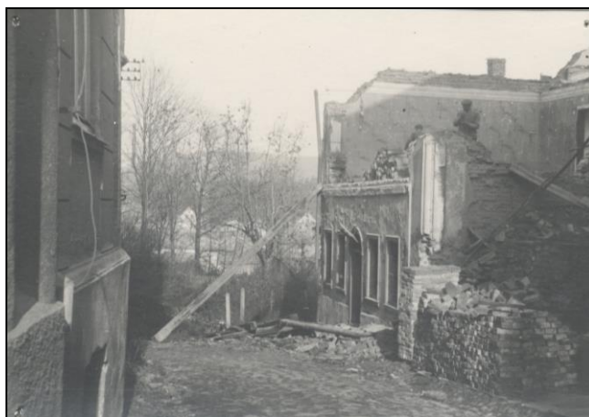
Demolice objektů č.p. 208, 209 a 210 v uličce Horní, 60. léta 20. století (MMR)
