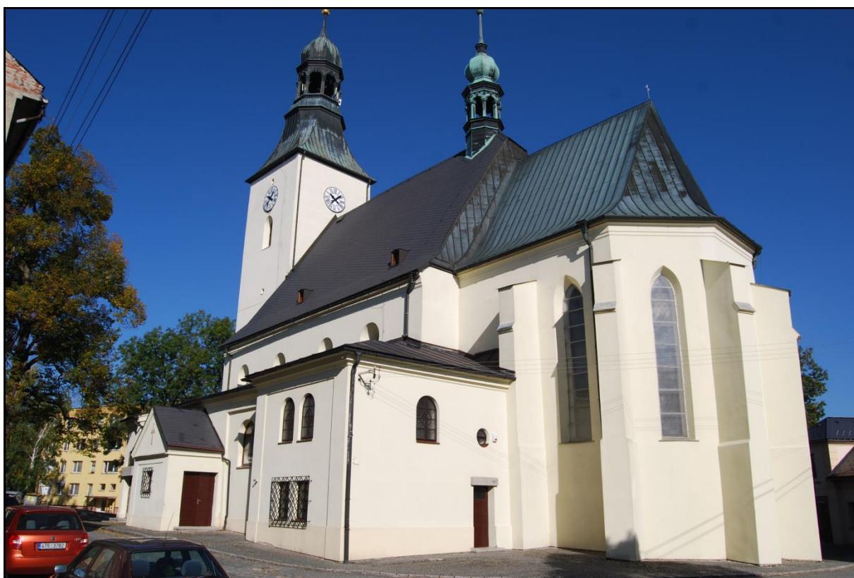
Pohled od jihovýchodu
