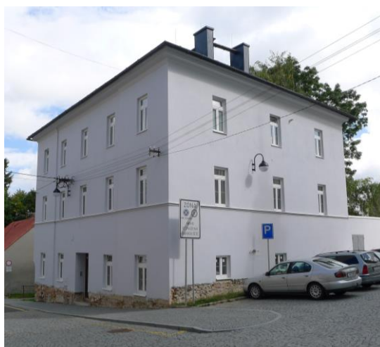
Obnovena fasáda na objektu č.p. 176/2 na ulici Národní
