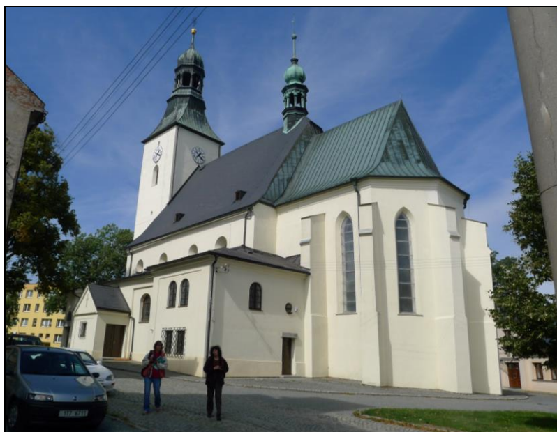
Školní náměstí s kostelem a budovou staré školy, jejíž původní architektonický výraz byl setřen úpravami v 70. letech 20. stol.
