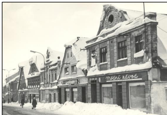
Pravá strana ulice Radniční před demolicí (MMR)
