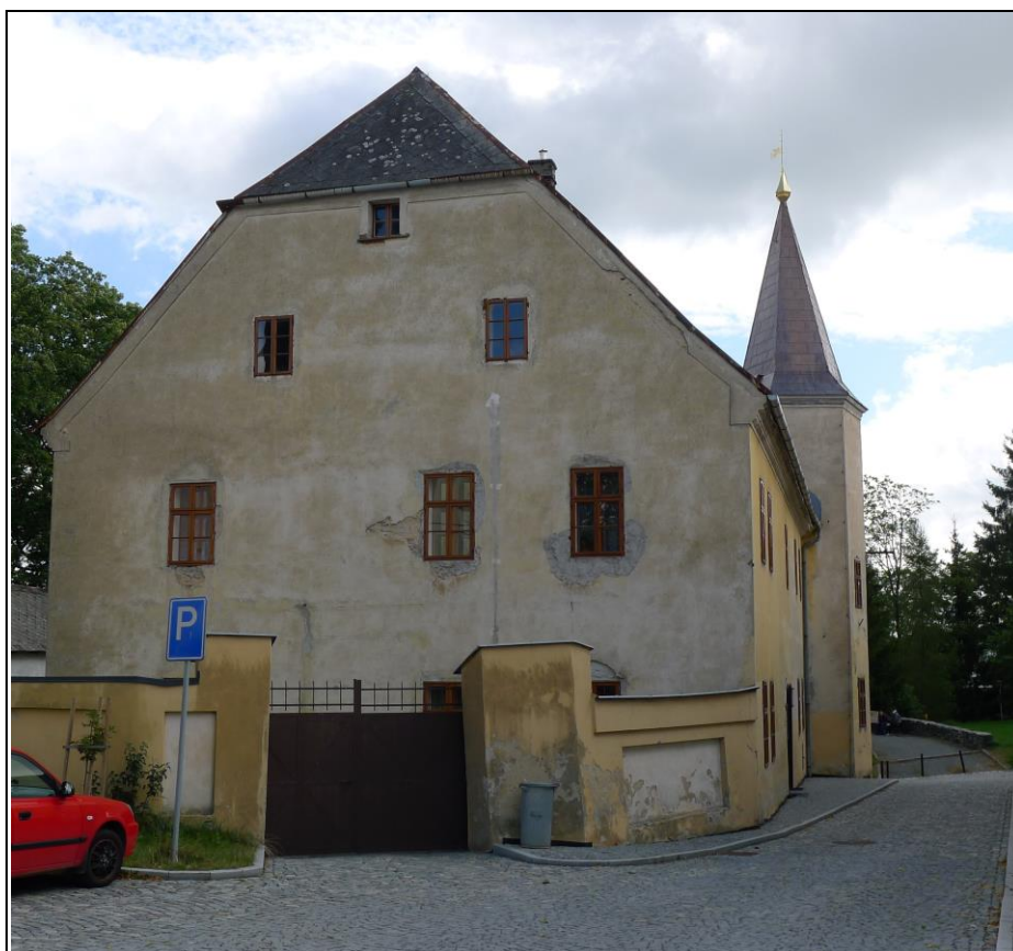
Stav po výměně oken a rekonstrukci zastřešení věže
