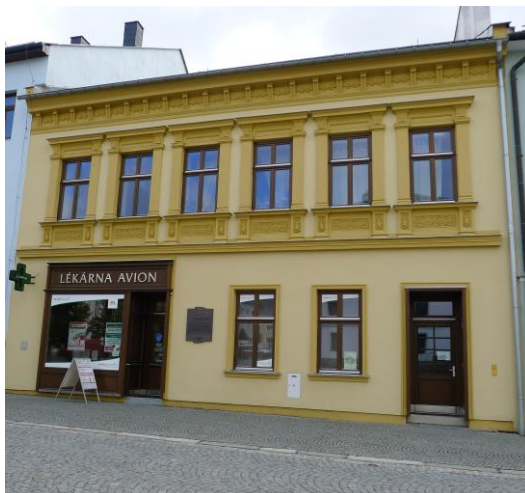
Obnovena fasáda na objektu náměstí Míru č.p. 205/30
