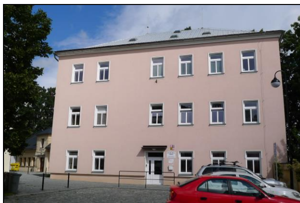
Objekt staré školy prošel řadou nevhodných stavebních úprav, které absolutně potlačily jeho původní architektonický výraz
