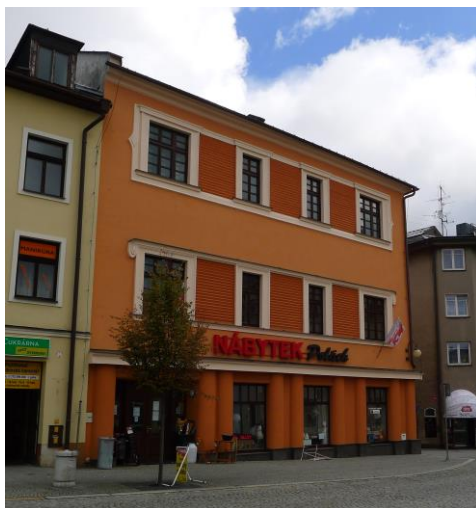
Obnovena fasáda na objektu náměstí Míru č.p. 216/3
