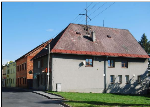
Souvislá patrová zástavba domů na začátku Husovy ulice
