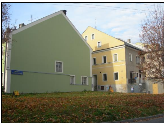
Štítová stěna domu tvořící součást zástavby jihovýchodní spojnice nám. Míru a Husovy ulice, na štítovou stěnu objektu původně navazovala další budova, dnes je prostor nezastavěný
