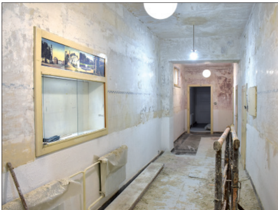
Chodba expozice s oškrábanou omítkou
