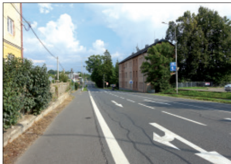
Ke zvýšení bezpečnosti chodců přispěje stavba chodníku na Opavské ulici
