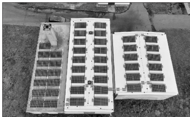
Budova v areálu čistírny odpadní vod
