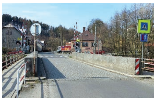
V Břidličné začne oprava mostu přes řeku Moravici
