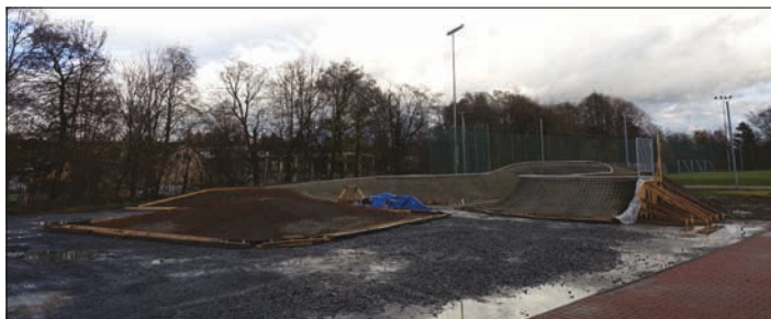
Stavba skateparku na ulici Žižkova
