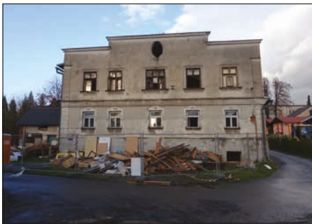
Demolice budovy na Máchově ulici
