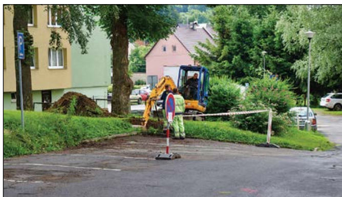
Komunikace na sídlišti Pivovarská až po Hornoměstskou ulici prošla rozsáhlou rekonstrukcí
