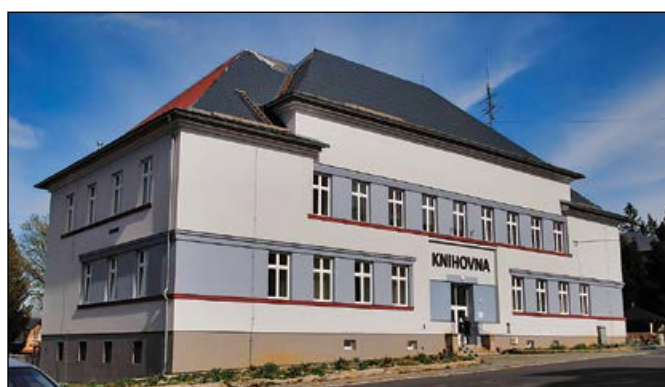
Objekt bývalého soudu byl přestavěn pro potřeby městské knihovny a Střediska volného času Rýmařov
