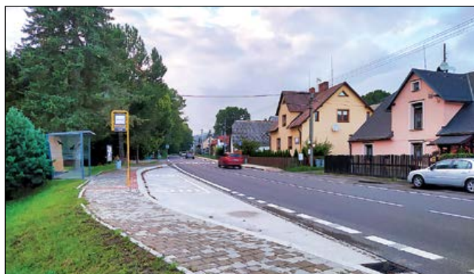
V Janovicích slouží nový chodník a přechody
