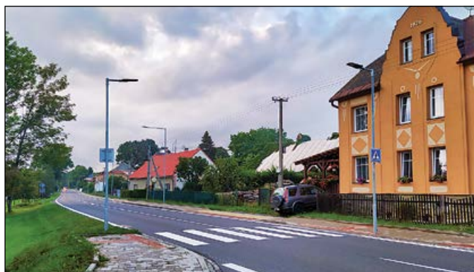
Veřejné osvětlení v části Rýmařova, Janovicích a Harrachově prochází postupnou rekonstrukcí
