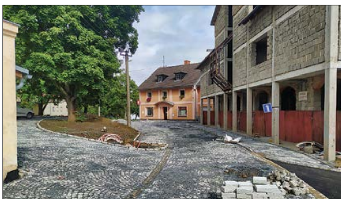
Regenerace Husovy ulice je před dokončením
