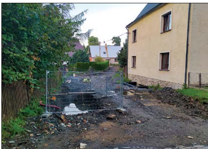
Probíhá rekonstrukce Bednářské ulice
