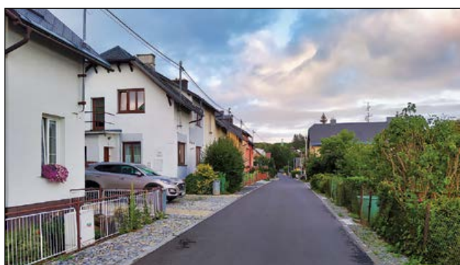
Byla dokončena rekonstrukce ulice U Rybníka
