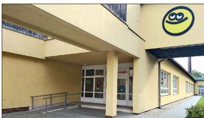
V budovách základní školy na Jelínekově a 1. máje byly modernizovány učebny, instalovány výtahy a posíleno internetové připojení
