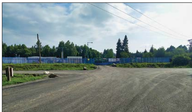
K čistírně odpadních vod jezdíme po nové cestě
