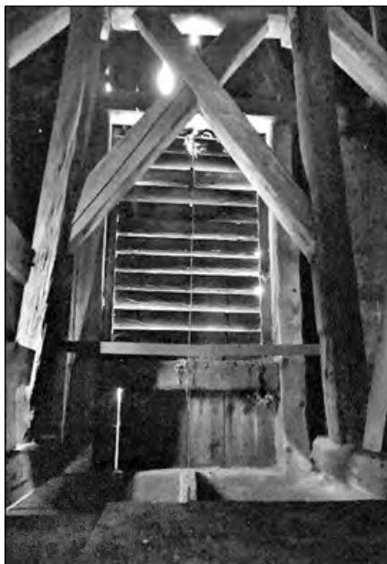
Rozpěrný ondřejský kříž ztužující rámovou konstrukci zvonořové stolice, v pozadí zvukové okno vyplněné dřevěnou žaluzií
