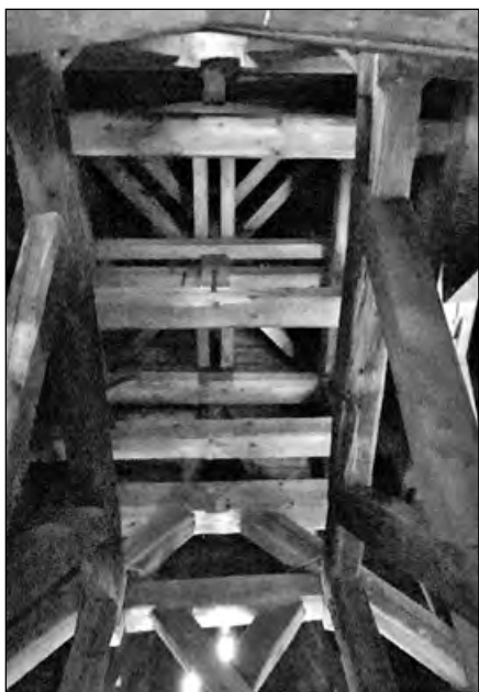
Průhled vestavěnou zvonořovou stolicí s křížovým ztužením rámové konstrukce do složitého krovu stavby
