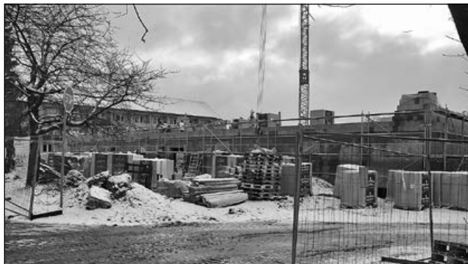
Stavba domu s pečovatelskou službou na Hornoměstské ulici
