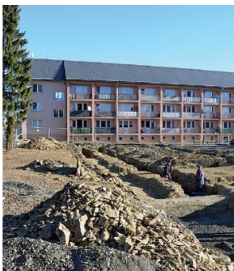
Začala výstavba nového domu s pečovatelskou službou
