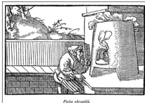
11. Kuželovitá pícka na tavení zlata (Agricola, 1556)
