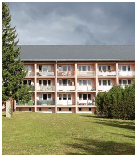
Začne výstavba nového domu s pečovatelskou službou
