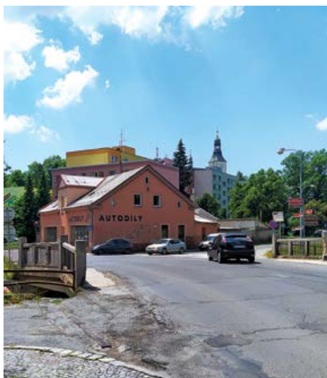
O prázdninách začne rekonstrukce mostu na Revoluční ulici
