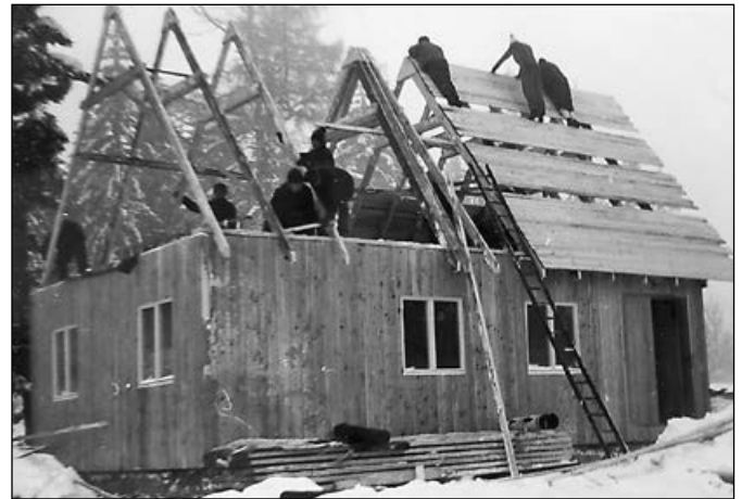
Při stavbě chaty
