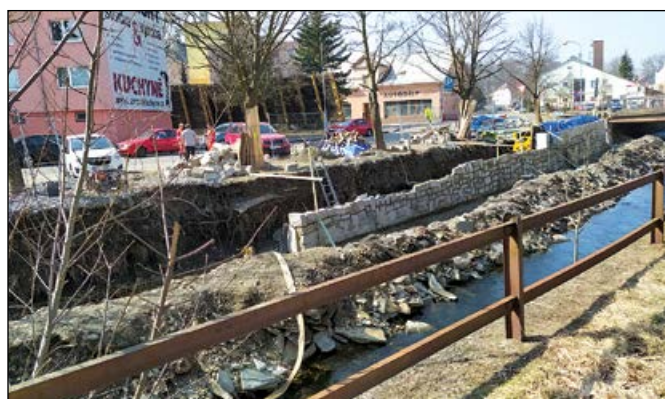
Povodí Odry buduje opěrné zdi u Podolského potoka. Foto: JS
