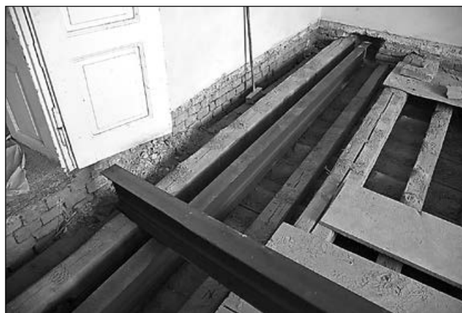
Vložení železných trámů mezi trámy původní
