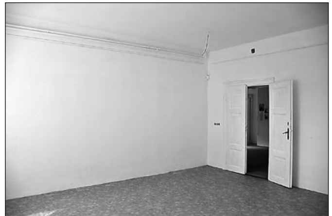
...a po rekonstrukci
