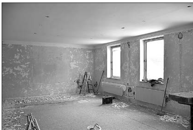
Velký sál Galerie Octopus před rekonstrukcí
