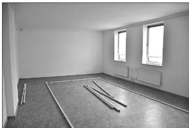
...a po rekonstrukci se světlý připravenými k instalaci
