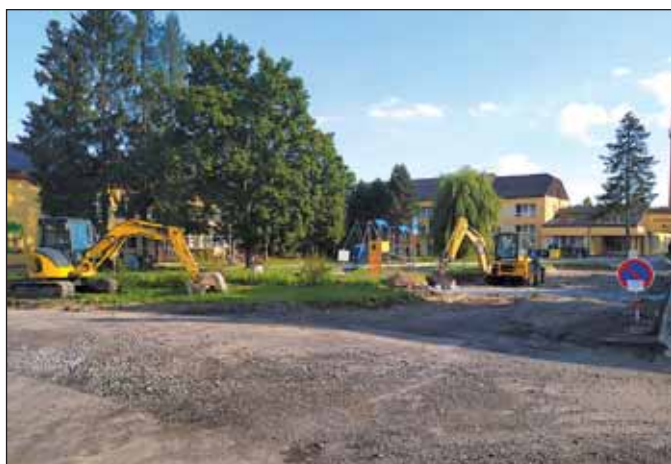
Na ulici 1. máje začala oprava komunikace
