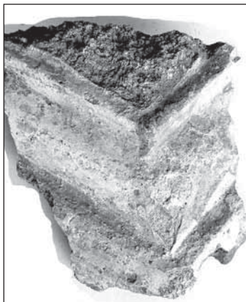
Část štukové římsy
