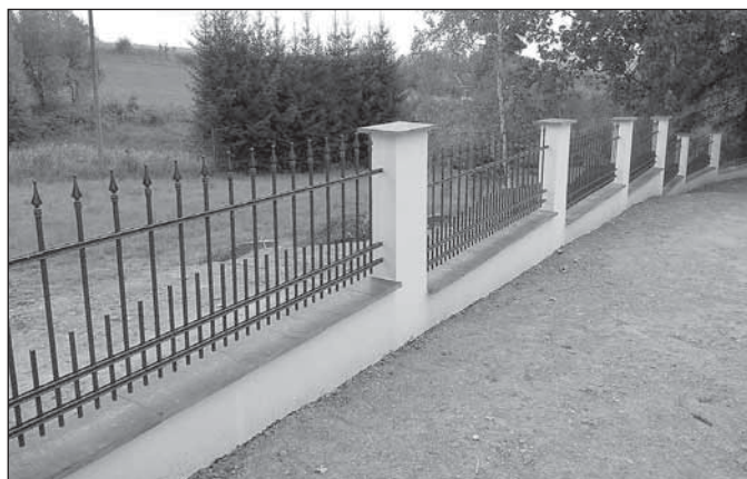
Rekonstruovaná hřbitovní zeď
