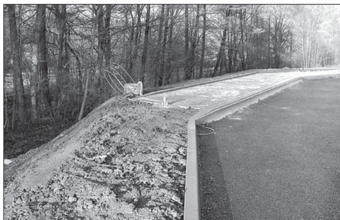
Budování nové autobusové zastávky ve směru na Břidličnou
