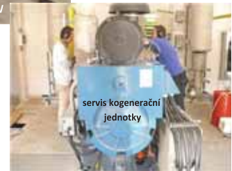
kogenerační jednotka BGA136/ 250kW
