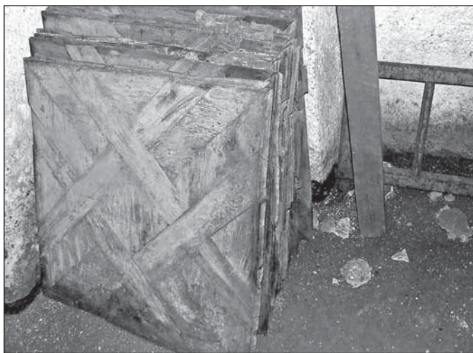
Parkety zničené vlhkem (sklep), používané natřeny rudým hydrovoskem (2007)
