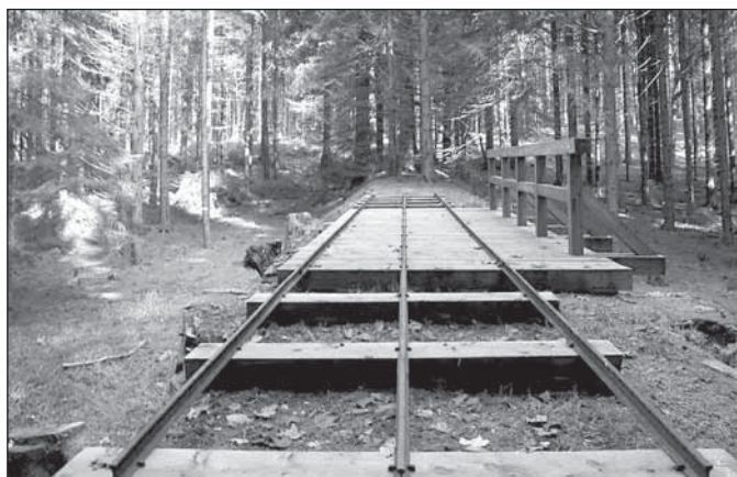
Svážnice překonávala výškový rozdíl 49 metrů
