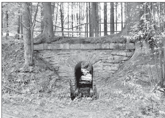
Branná - mostek po bývalé lesní železnici pod hájovnou Banjaluka, foto: www.ceskehory.cz
