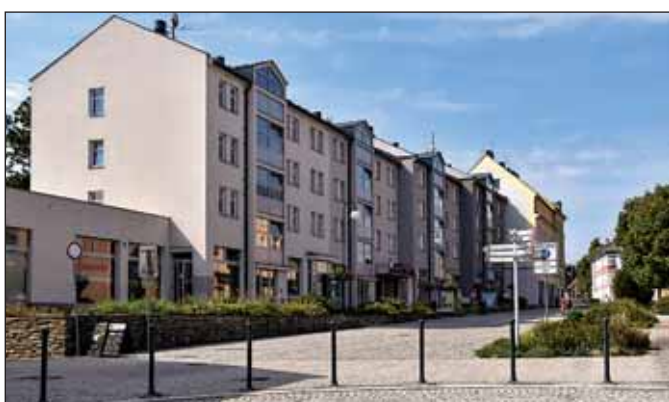
Stavební úpravy budov na Radniční ulici 1, 3, 5, 7 a revitalizace ulice Radniční a Hrádku
