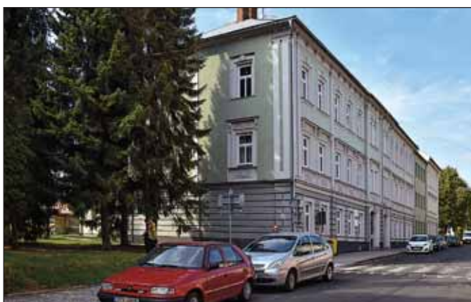
Rekonstrukce budovy bývalé SSOŠ Prima v rámci energetických úspor
