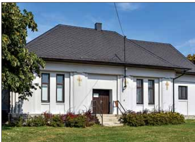
Oprava správní budovy hřbitova
