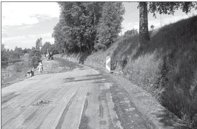
Oprava komunikace v Jamartících
