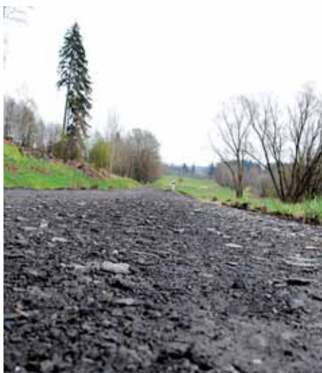
Uzavírka: Pokračuje rekonstrukce silnice Jamartice – Velká Štáhle
