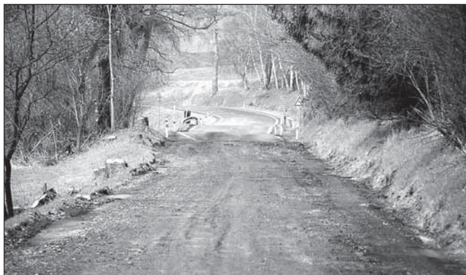
... a dále od opraveného úseku směrem ke křižovatce u stáčírny plynu
