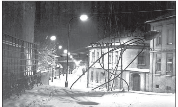
Kovová konstrukce na dnešní třídě Hrdinů, 1957
