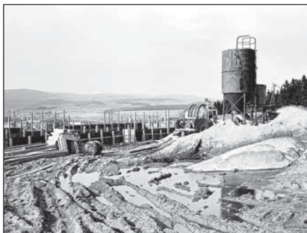
Výstavba vodojemu na Stráni, 1970
