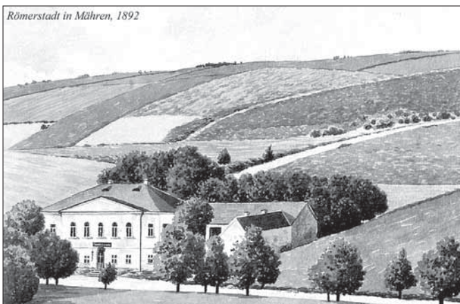
Původní tkalcovna hedvábí bratří Schiellů (1892) určená k demolici
