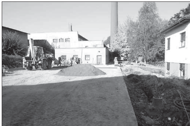
Úprava zpevněných ploch v areálu Teplá Rýmařov, s. r. o.
