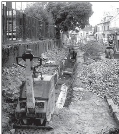
Výměna plynovodního potrubí na třídě Hrdinů (foto: redakce)
