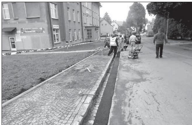
Oprava chodníku na Pivovarské ulici
