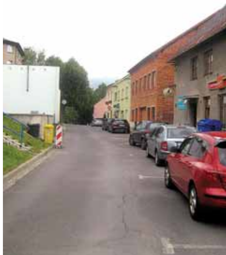
Oprava plynovodu omezí parkování na Husově ulici
