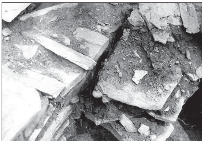
Přístavba venkovní části obranné zdi na spáru vedle brány
