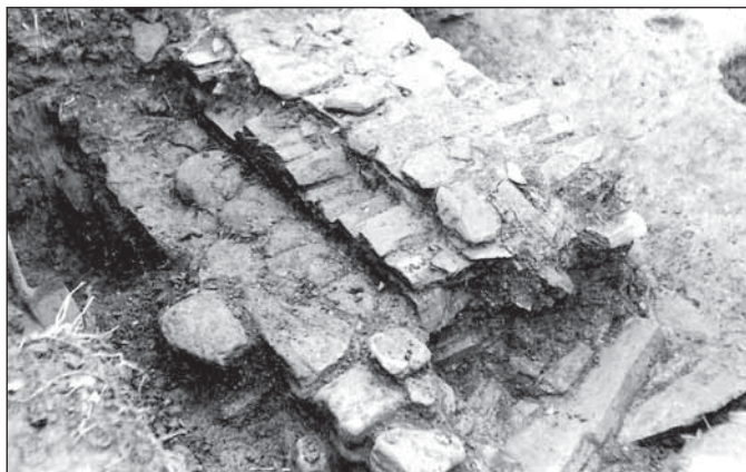
Nižší část zdi vlevo je přístavbou k vyšší původní kamenné hradbě vpravo
