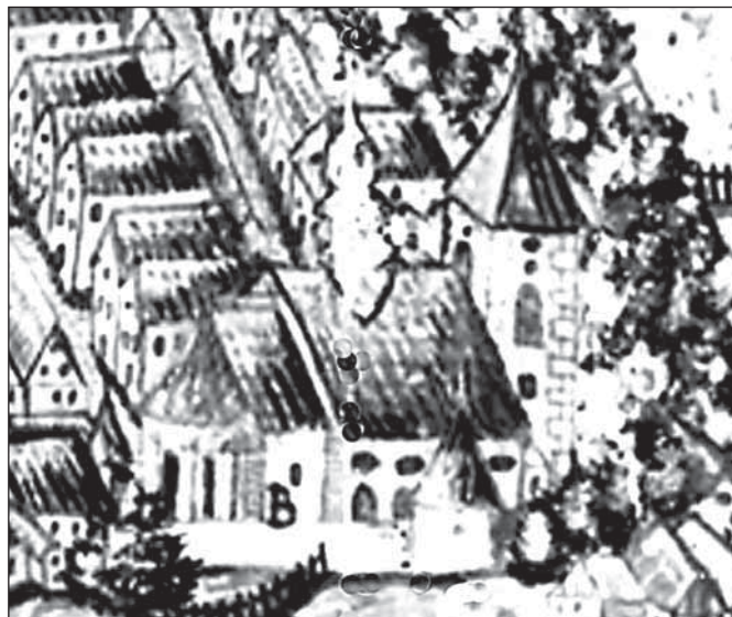
Výřez z veduty děkana Schmidta (1693), pod kostelem opevnění s půlválcovou baštou
