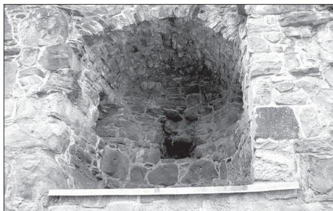
Vnitřní část otevřené půlválcové bašty, dolní část zřetelně zazděna (Zeil)
