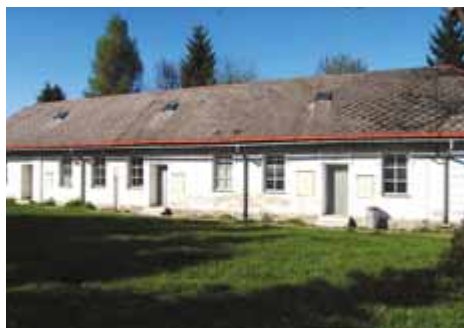
Zastupitelé schválili demolici holobytů v Edrovicích
