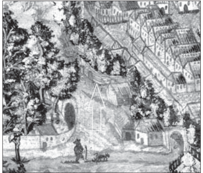
Hradební zeď s výpadovou brankou, vlevo barokní hřbitov, v pravém dolním rohu Hřbitovní brána a dvě pásma plaňkového opevnění, vpravo brána na hřbitov, márnice či hřbitovní kaple se vchodem zvenčí
