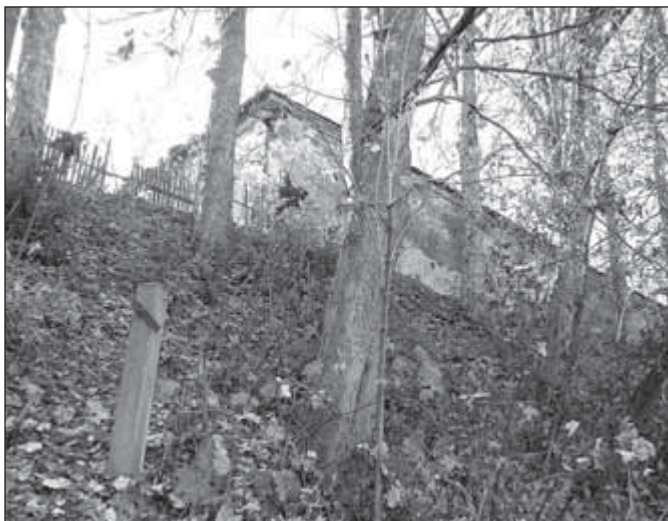
Vnější stěna hospodářských budov děkanství
