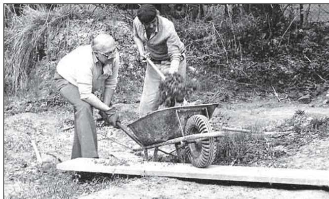
Odkrývání vnitřní hrany příkopu Hrádku (vpravo Ing. Novák)
