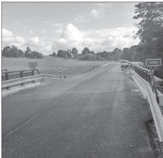
Část zrekonstruované komunikace vedoucí do Jamartic
