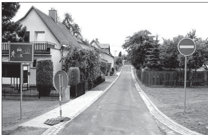
Zrekonstruovaná komunikace na Lidické ulici
