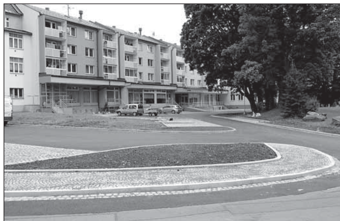
Komunikace a parkoviště v lokalitě Hrádku těsně před dokončením
