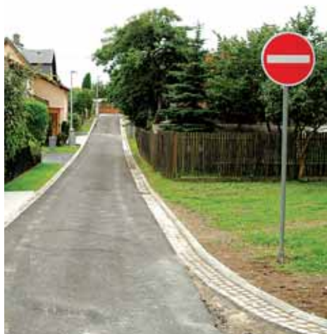
Rekonstrukce Lidické ulice a parkoviště v lokalitě Hrádku je dokončena
