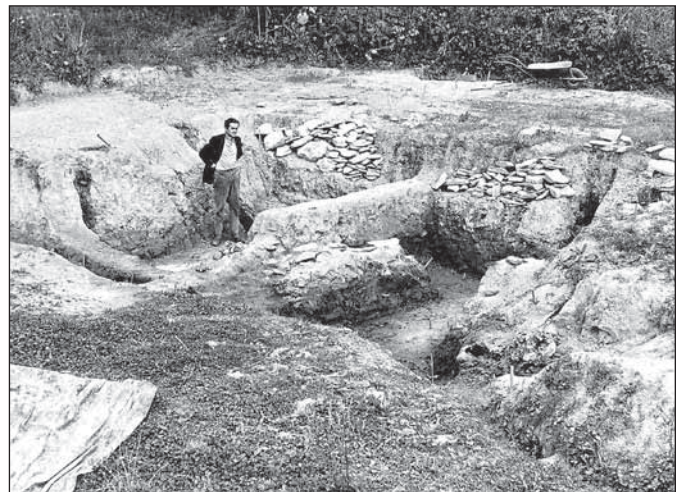
Celkový pohled na největší dům řemeslníka (obj. XIX) s kontrol. blokem (zbytky konstrukce svislých nosníků stěn a střechy)
