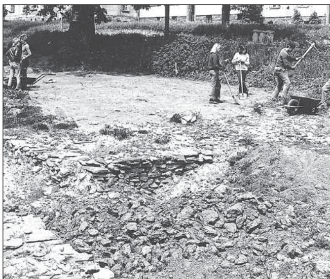
Dům s kamennými základy (zasypávání)
