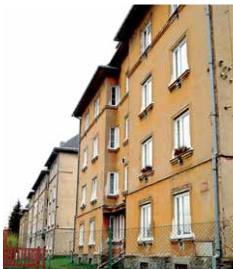
Zateplení se dočkají další bytové domy ve městě
