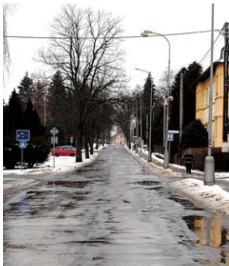
Největší investicí roku 2016 bude rekonstrukce Hornoměstské ulice
