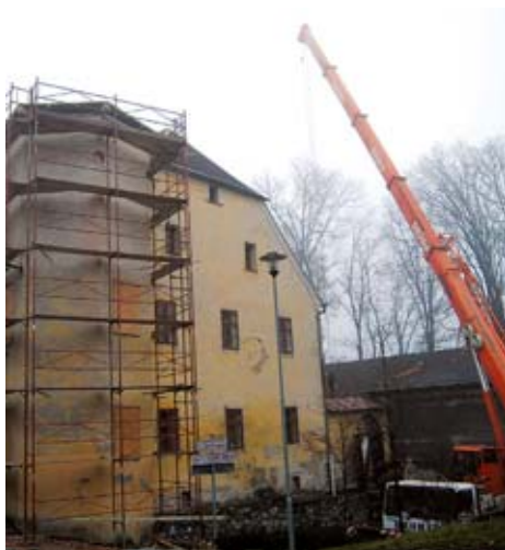
Tesaři pracují na opravě střechy farní věže
