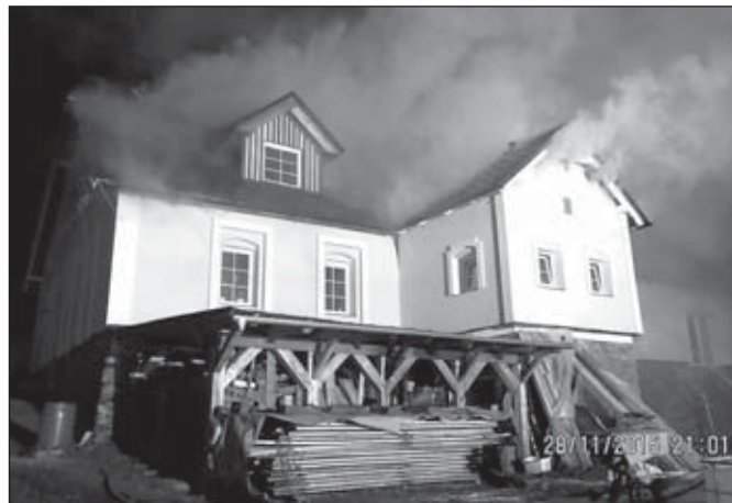
Požár střechy RD v Lomnici
