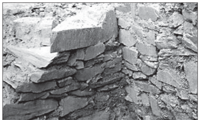
Spojení zdí téhož objektu
