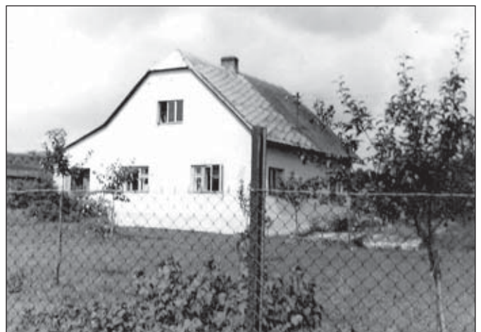
Bývalá kolárna ve Staré Vsi přestavěná na rodinný domek
