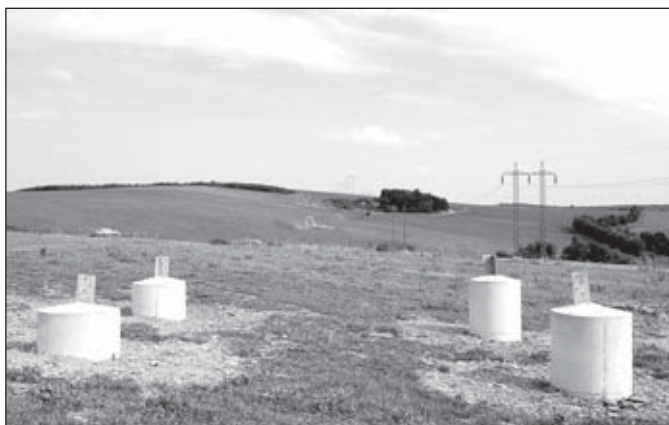
Betonové patky stožáru mezi Rýmařovem a Ondřejovem Foto: JiKo
