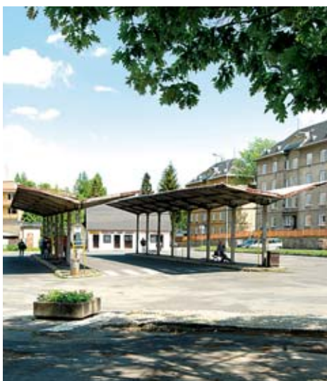
V červnu začne rekonstrukce auto- busového nádraží a Školního náměstí
