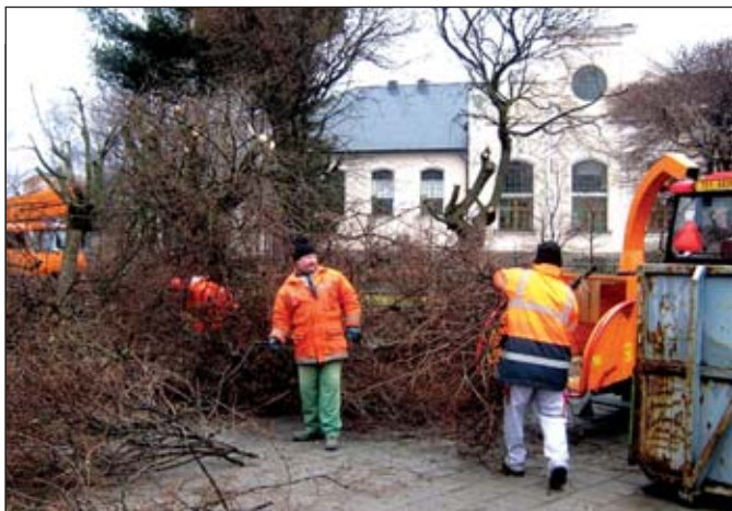
Kácení a ořezy dřevin se prováděly na území celého města. Ořezávaly se větve provozně nebezpečné, suché a ty, které překážejí průjezdné šířce u komunikací. Razantní ořez takzvané „na hlavu“ se provádí pouze se souhlasem odboru životního prostředí městského úřadu, například u stromků mezi prodejnu Rýmařovanka a Podolským potokem.
