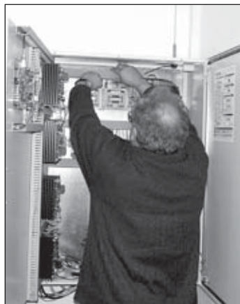
Instalace sirény v Lomnici
