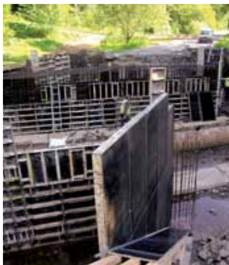
Práce na rekonstrukci silnice do Dlouhé Loučky pokračují podle plánu
